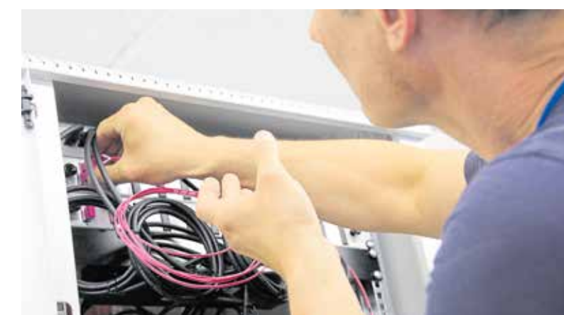
Montage von Sicherheitstechnik durch einen Mitarbeiter der ESRA GmbH aus Reichenbach. Das Unternehmen ist offizielles Errichterunternehmen von Überfall- und Einbruchmeldeanlagen des Landeskriminalamtes Sachsen und einer der maßgeblichen Mitorganisatoren des Sicherheitstages. Foto: ESRA GmbH
